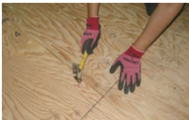
釘などの突起物の頭は表面が平らになるよう、打ち込む
