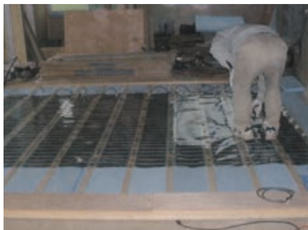
ヒーターの『釘打ち範囲』と根太が重なるように置く
