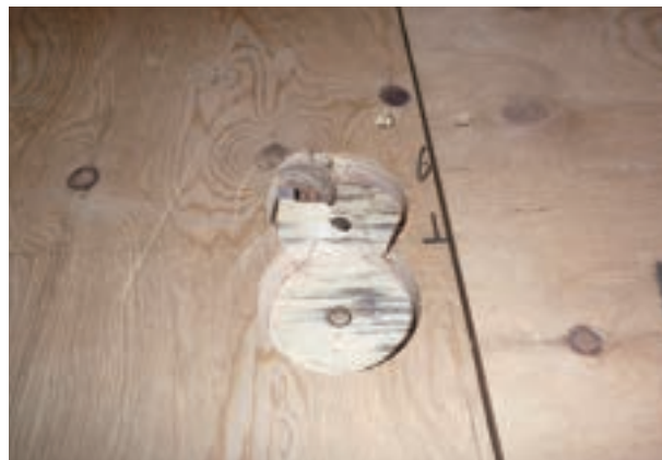
連結させた座彫りに、コードを落す小さな穴をあける ※2階の場合は1階の天井内で結線する
