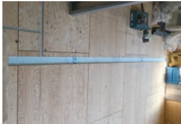
下地合板に70mm程度の溝を切る
