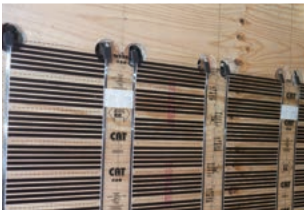
同様に、すべての渡り線を床下に落とす
