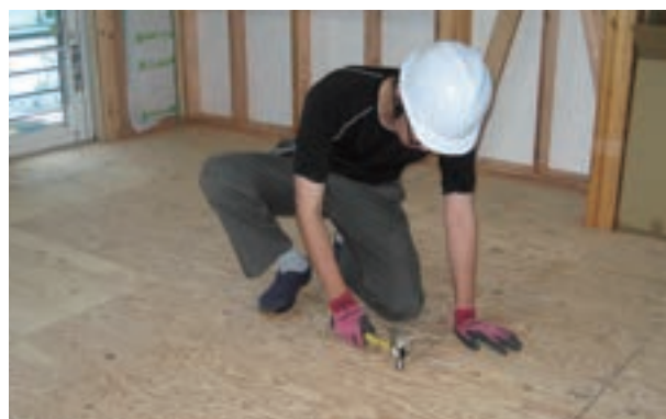
構造用合板の表面に節などの突起物がある場合は必ず平滑にする
