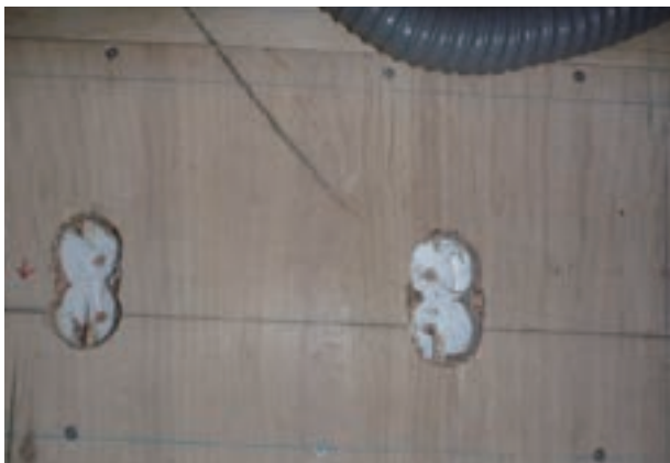
穴の大きさのバリエーション 40mm程度を2連、座彫りする
