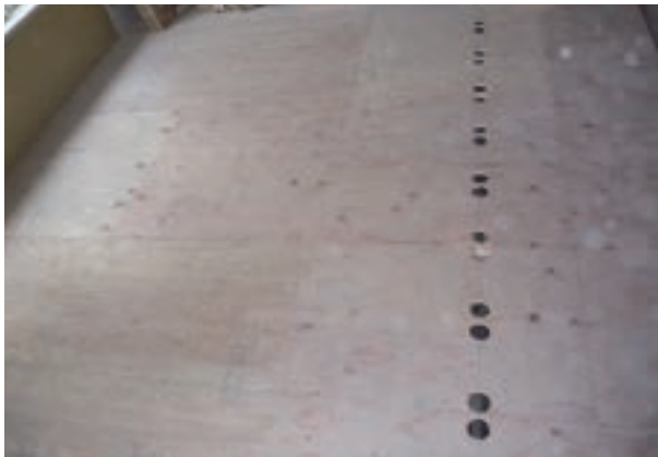
ヒーターの渡り線の位置に、 直径70mm位の穴を開ける
