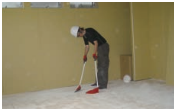
ヒーター敷設の前・後には必ず清掃をし、小破片がないことを確認してください
