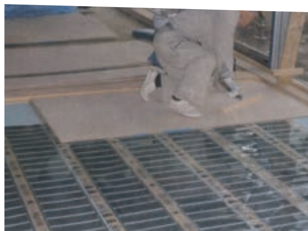
ヒーターをガンタッカー(コンプレッサー仕様でないもの)で仮止めする。
