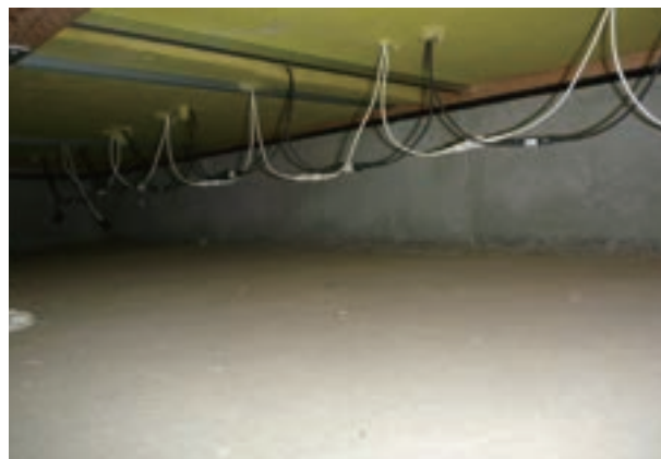
床下でヒーター配線(P6とP7)を参照し、結線する
